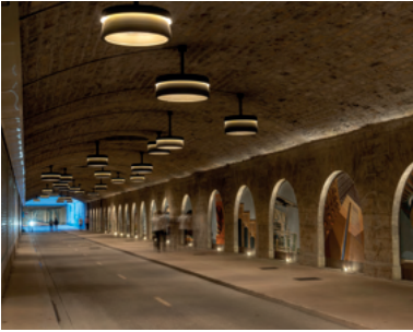
Voûte France Péjot, Gare Perrache
