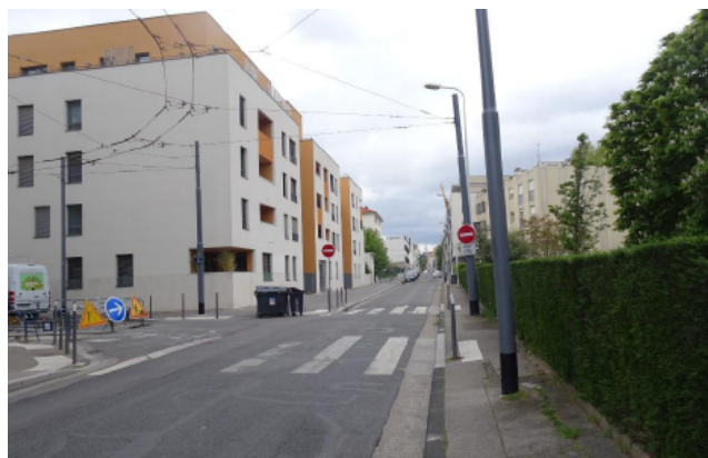
Carrefour rues Henri Gorjus et Clos Savaron : exemple d'un cheminement peu confortable : trottoirs étroits avec pylônes et poteaux.
