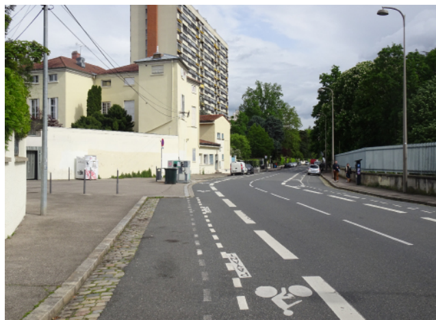
Rue Chazière (entre rue Ferré et rue Bony) : exemple d'un cheminement sans banc sur environ 450 m : possibilité 1 ou 2 bancs à mi-chemin ?
