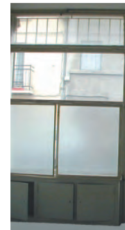
Combinaison de vitrage clair anti-effraction en partie haute et de volets intérieurs en partie basse en vitrage sablé pour la vue, avec un apport de lumière maximum.
