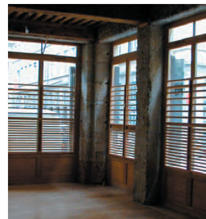
Système de persiennes intérieures jouant le rôle de pare-vue progressif. Il donne un sentiment de protection. Il est associé à des volets bois extérieurs lors des absences prolongées des occupants.
